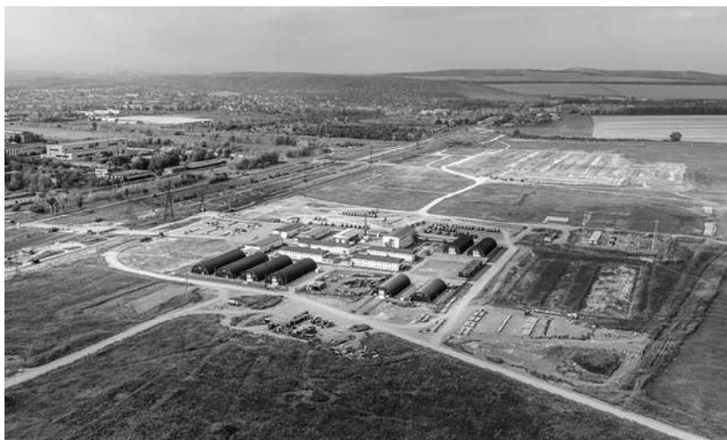
Рис. 1. Строительство цехов сварки и окраски в Усть-Каменогорске
